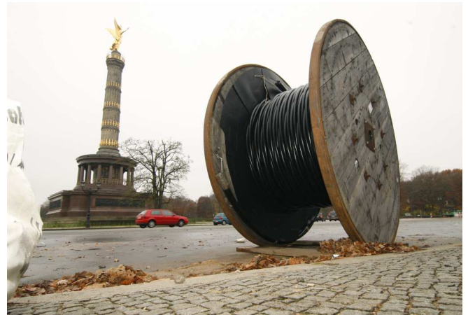
Foto: Im Stadtgebiet werden neue Kabel für eine moderne Infrastruktur verlegt.
