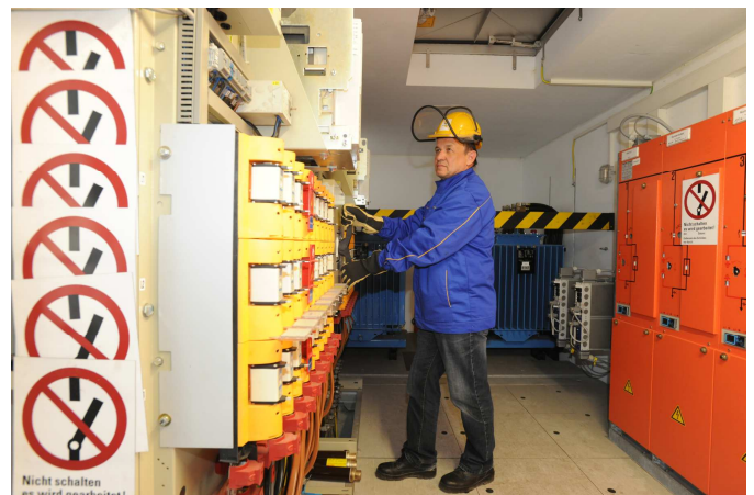
Foto: Ein Mitarbeiter der Stromnetz Berlin GmbH kontrolliert die Anlagen in der unterirdischen Netzstation. Sie sorgt im Bereich des Brandenburger Tores für die nötige Energie.
