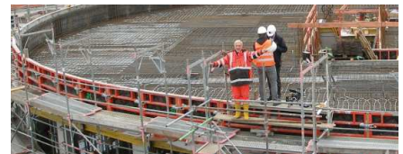
Foto: Gruß vom Dach nach getaner Arbeit.
