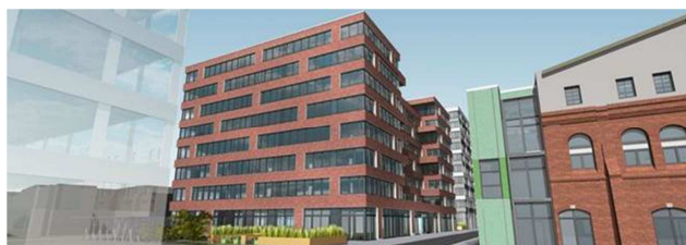
Foto: Im Bau befindlicher neuer Firmensitz von Berliner Synchron
