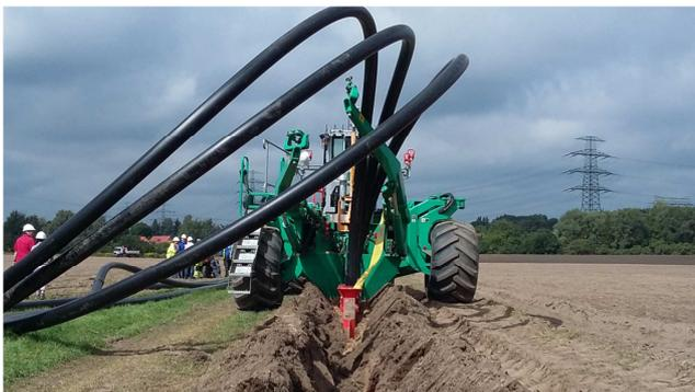
Bei dem Verfahren wird der Boden entlang der Trasse kurz „angelüftet“. Mit einer Kraft von bis zu 200 Tonnen zieht der Kabelpflug danach die vorbereiteten Leerrohre in den Boden ein und drückt die Erdschichten direkt im Anschluss wieder in ihre ursprüngliche Position.
