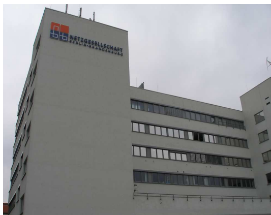
Foto: Das Gebäude der NBB auf dem EUREF-Campus am Schöneberger Gasometer.
