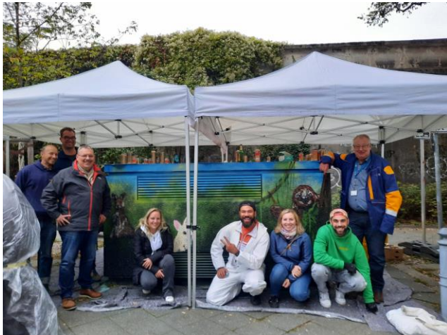
Trafostation 74331, Varziner Str. 3, 12159 Berlin-Friedenau, Stromnetz-GF Thomas Schäfer, Big Moe Radio-Moderator (im weißen Overall mit schwarzem Basecap) sowie Mitarbeiter der betreuenden Vereine meredo e.V. und Helliwood media & education. Foto: Stromnetz Berlin
