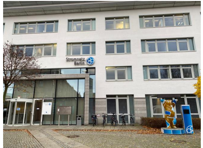
Der Firmensitz der Stromnetz Berlin GmbH in der Eichenstraße in Alt-Treptow – Foto: Ed Koch
